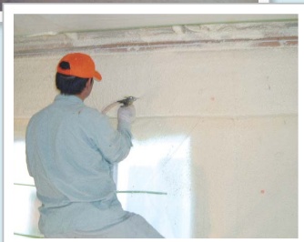
壁面吹きつけ
