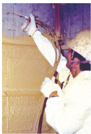
壁面吹きつけ
