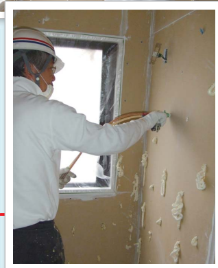
GL工法の改修
