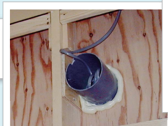
ダクト・ 電気配線まわりの 充てん
